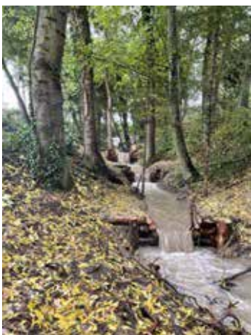
Remise en état du Ruisseau de Gruon
