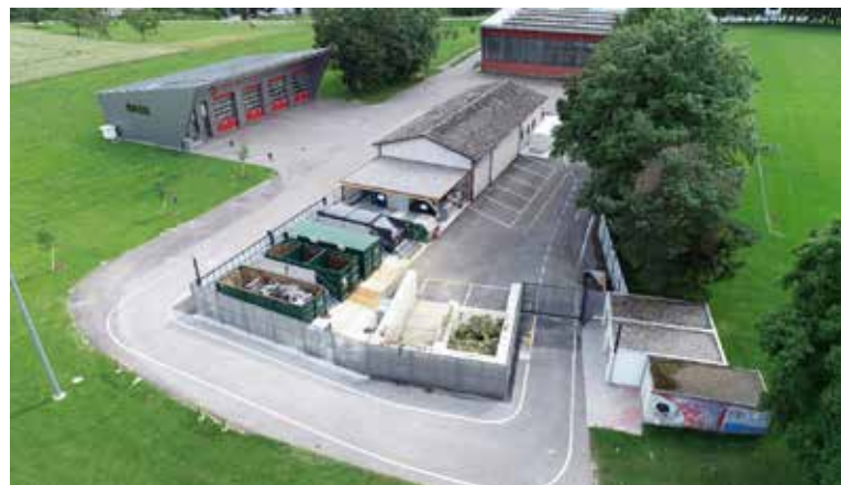
Restructuration de la déchetterie
